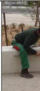
Si les banquettes sont posées alignées, nous prévoyons un jeu de 5 mm entre deux banquettes, pour éviter les épauffrures dues à la dilatation et à la pose. Une cale est scotchée verticalement pour cela.
